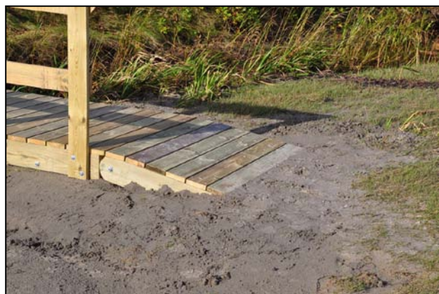
UPPKÖRNINGSSRAMPEN ÄR KLAR
